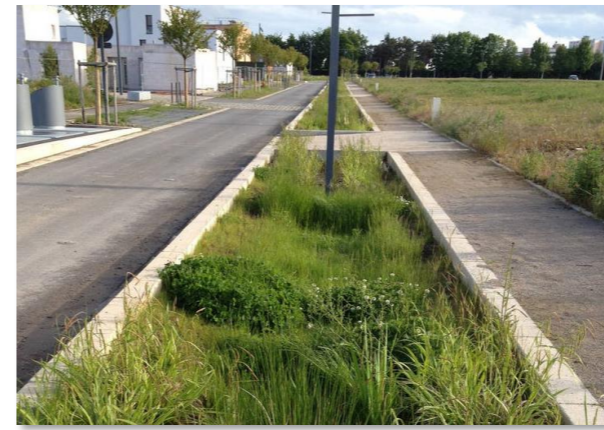
Noue urbaine à plantes semi-aquatiques
