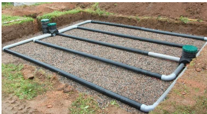
Exemple de filtre à sable vertical
